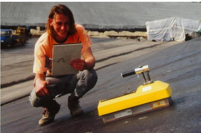
Abb. 3: Zerstörungsfreie Dichtebestimmung mit der Isotopsonde
